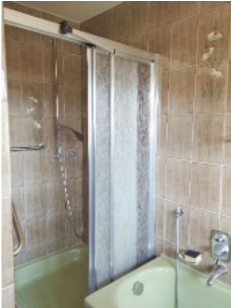
Großes, helles Tageslichtbad mit Wanne und Dusche
