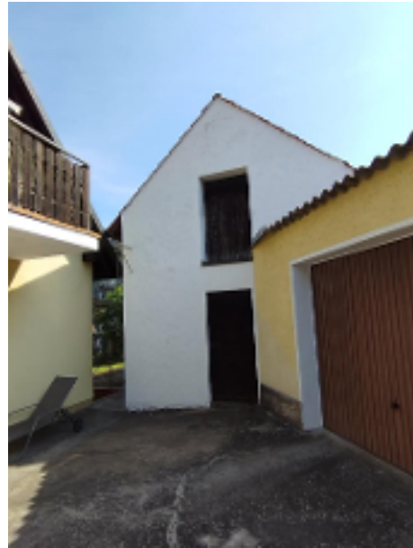
Teilansicht Haus, massives Nebengebäude und Garage
