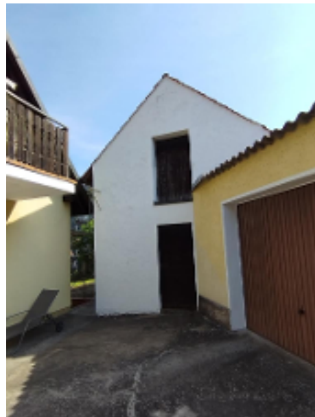
Teilansicht Haus, massives Nebengebäude und Garage
