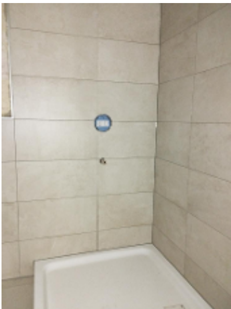
Dusche ist schon fast fertig
