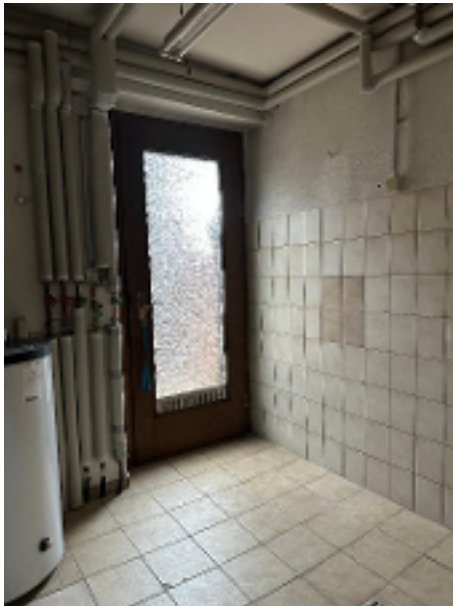
Hauswirtschafts.- und Technikraum
