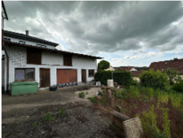
Nebengebäude mit viel Platz für Handwerker
